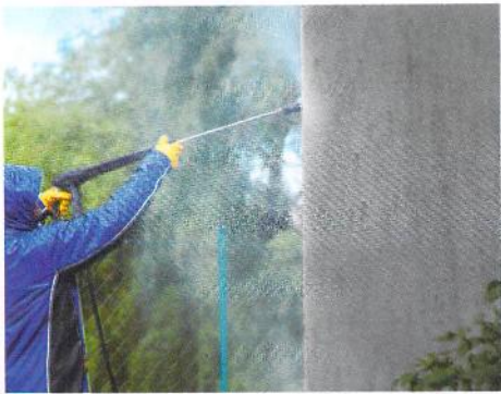
Reinigung der Oberfläche
